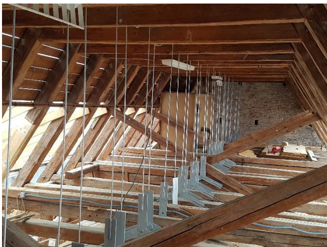
Y-förmige Metallverspannungen zur Verbesserung der Stabilität des Dachstuhls. Foto: Hermann Mader
