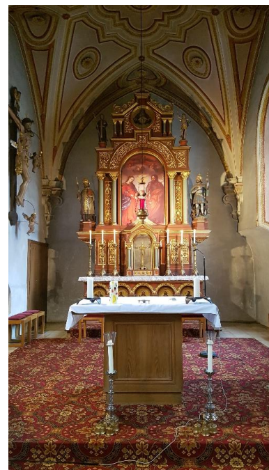
Bild 1: Renovierungsbedürftiger Innenraum der Pfarrkirche St. Korbinian Unterhaching,
