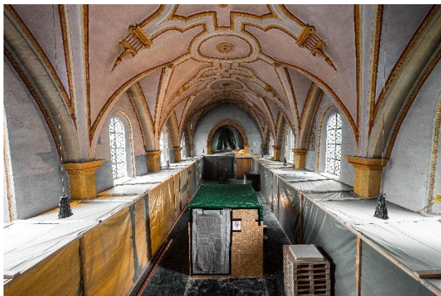
Errichtung eines Staubtunnels mit Absaugvorrichtung für den Baustaub
