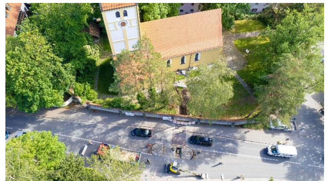
Anschluss von St. Korbinian an die Fernwärme der Geothermie Unterhaching in der Ottobrunner Straße, nördlich der Kirchenmauer. Fotos: Alexander Petek.
