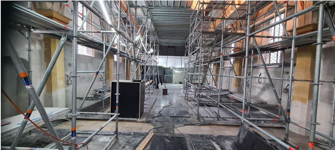
Aufbau eines Baugerüsts für die Bearbeitung der Innenwände der Pfarrkirche. Foto: Hermann Mader
